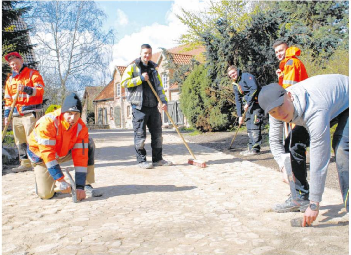
Der Kirchenweg in Lambrechtshagen zum Pfarrhaus und zum Begegnungshaus wurde von den besten Straßenbauer-Azubis mit Feldsteinen in mittelalterlicher Bauweise gepflastert. In dieser Woche haben die Lehrlinge ihr Werk übergeben. FOTOS: DORIS KESSELRING
