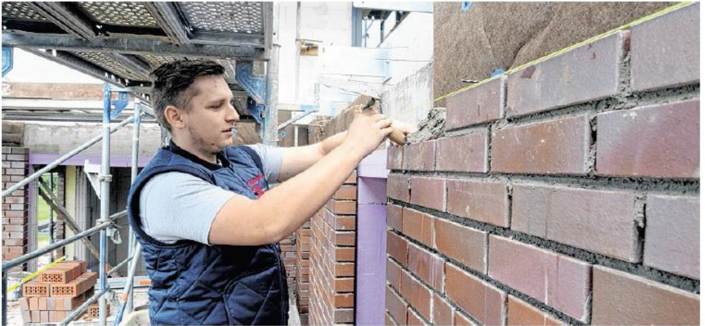
Gestern auf der Baustelle in Stockelsdorf, heute bei der Freisprechung in der Grevesmühlener Malzfabrik: Jan „Stift“ Ahrens von der SZ-Bau GmbH erhält die Auszeichnung als bester Lehrling. FOTO: MICHAEL SCHMIDT
