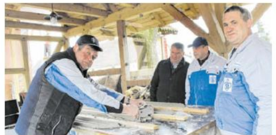
Bauleute der Firma demonstrierten den Gästen, wie langwierig das Ziehen von Stuckleisten ist. Schicht um Schicht muss aufgetragen werden.
